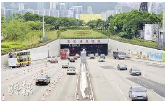
海底隧道現時面貌
